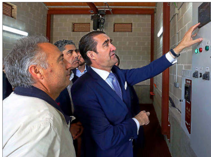
Juan Carlos Suárez-Quíñones visita las nuevas instalaciones. ICAL
